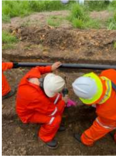
TENDIDO DE LINEA
