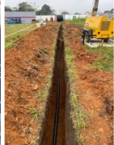
ZANJA DE INSTALACION
