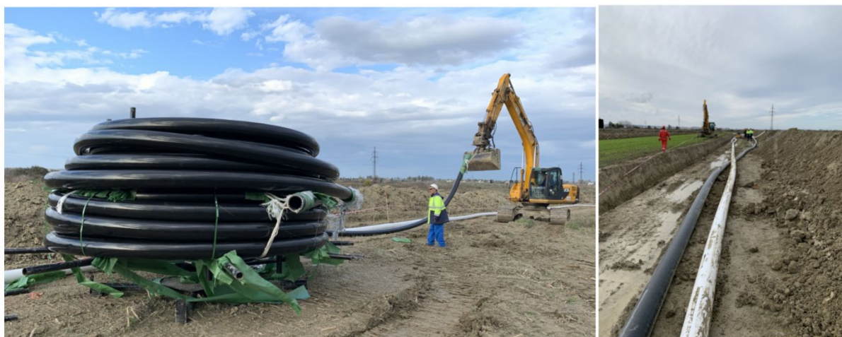
Figura 3.2: Desenrollamiento de tubería en el campo usando tractor excavador.
