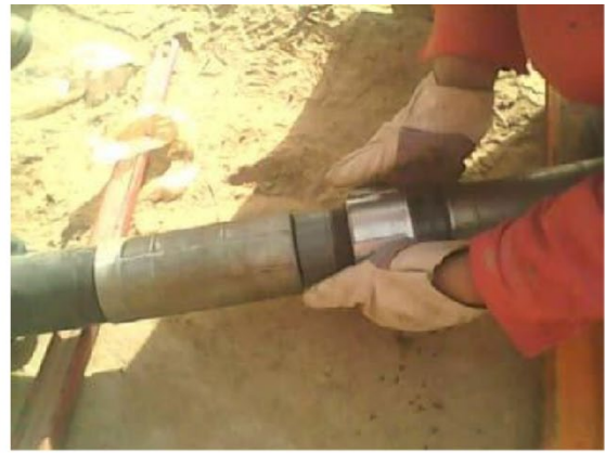
Figura 4.7 - Conexión de tubería.
