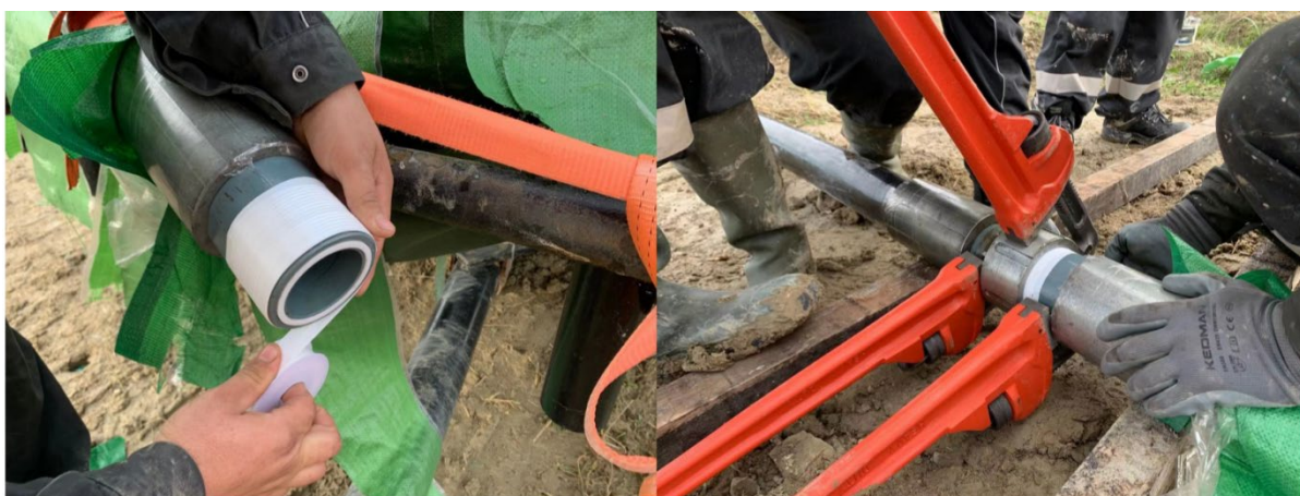
Figura 4.3: Conexión Buckle-press SS316L.
