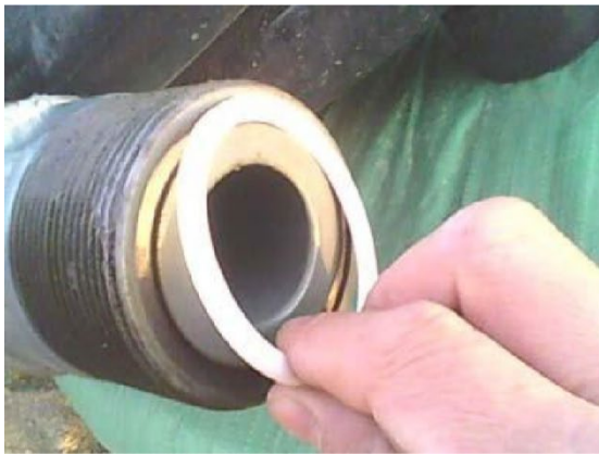
Figura 4.6 - Anillos de junta tórica.
